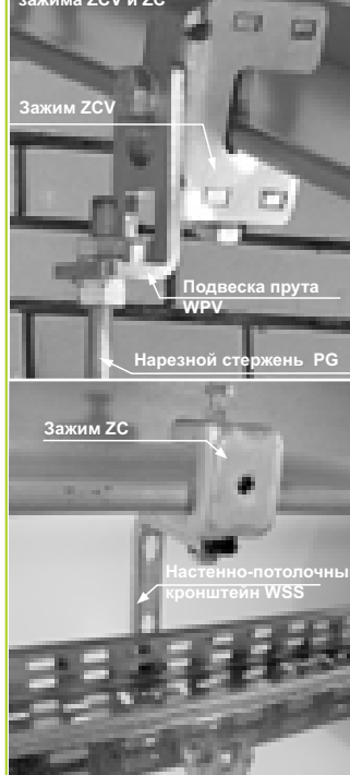
Пример использования зажима ZCV и ZC
