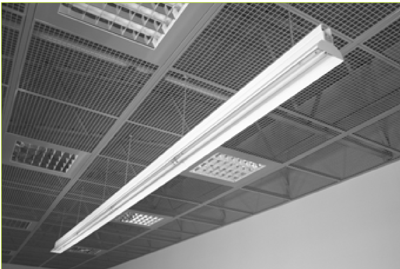
Пример монтажа отражателя ODL, корпуса и шины отражателя SOD
