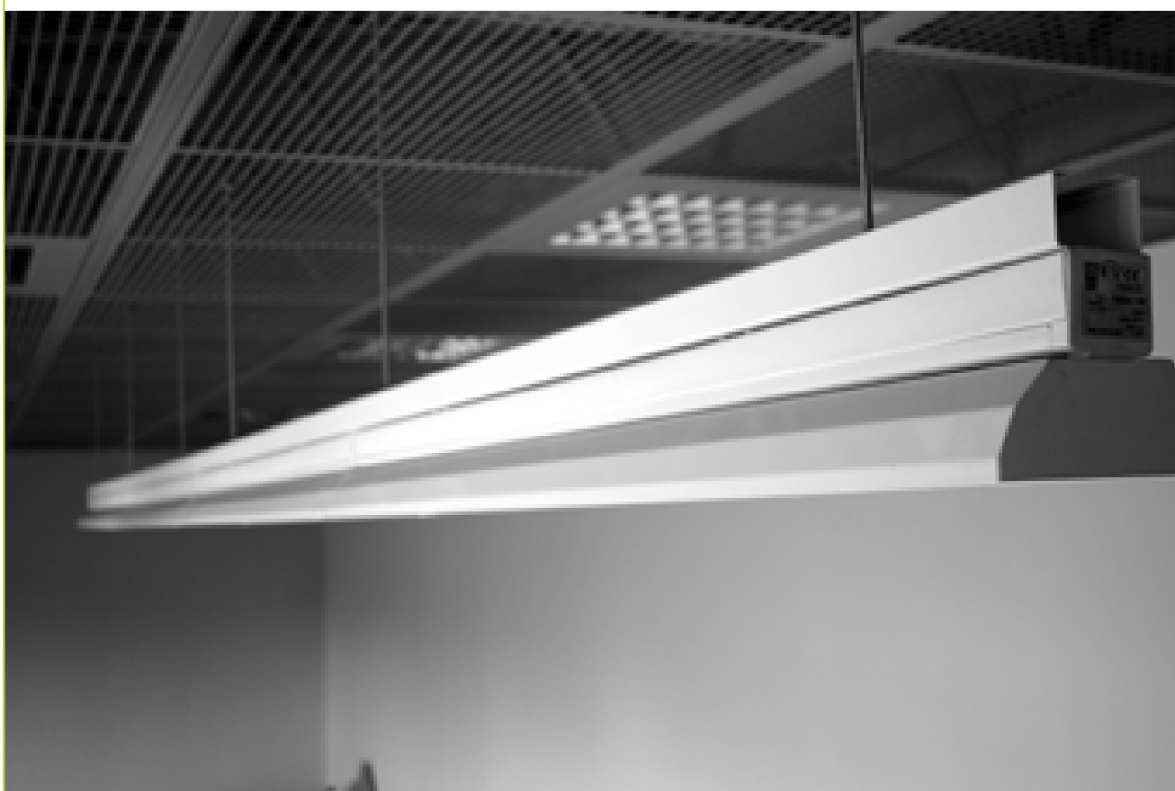
Пример монтажа отражателя ODL, корпуса и шины отражателя SOD
