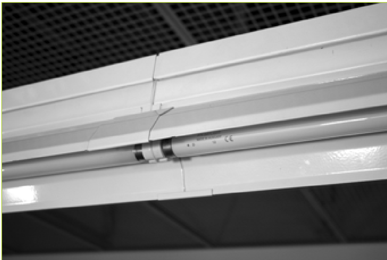
Пример использования соединителя отражателя LOL
